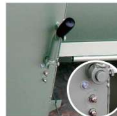
油注入口(機械室外)
